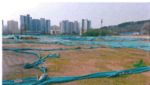
项目内的平整地面
