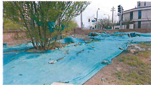
项目内的围墙
