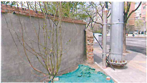
项目内的围墙
