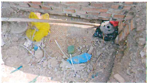
项目内的热力井
